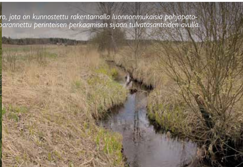
Kuvat 110 ja 111. Sipoon Ritobäckenillä toteutetussa luonnonmukaisessa peruskuivatushankkeessa uoman vedenjohtokykyä parannettiin kaivamalla uoman luiskaan tulvatasanne, joille vesi nousee tulva-aikoina (oik.). (Kuvat: Harri Aulaskari).
