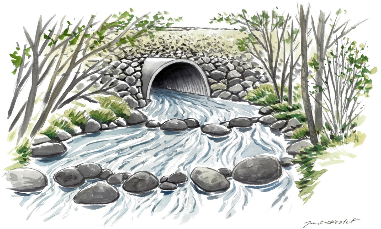
Kuva 4. Rummun alapuolen kivistynnykset varmistavat riittävän vesisyvyyden rummussa.
